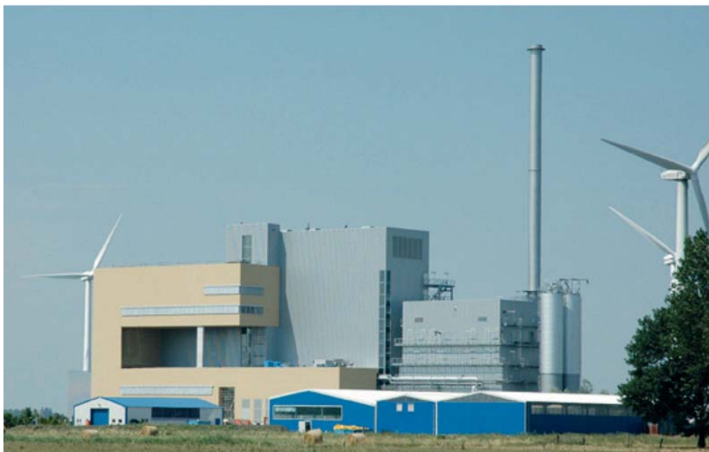
Abb. 10: EBS-Kraftwerk Weener (Germany)
